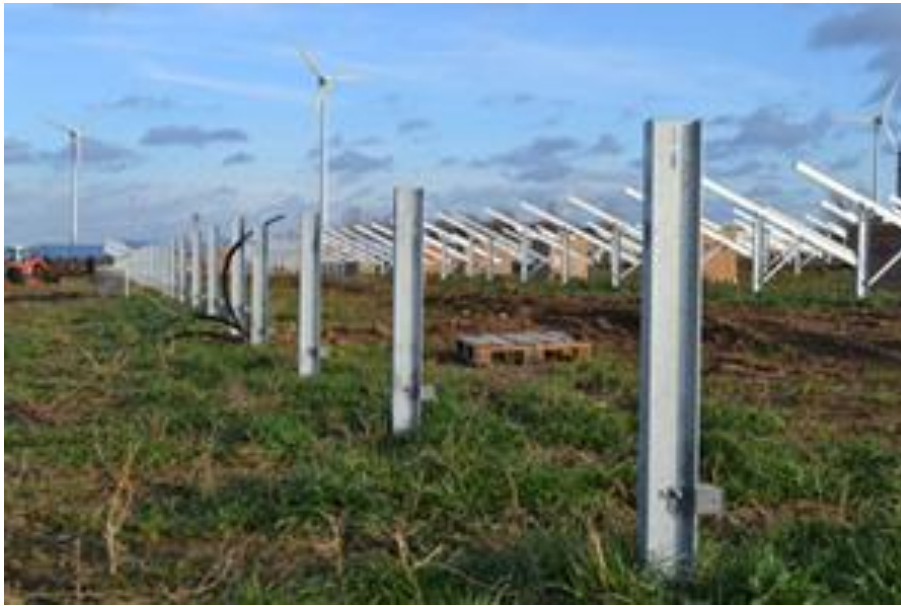
Zdjęcie 4 Profile metalowe: podstawowy element konstrukcji.
