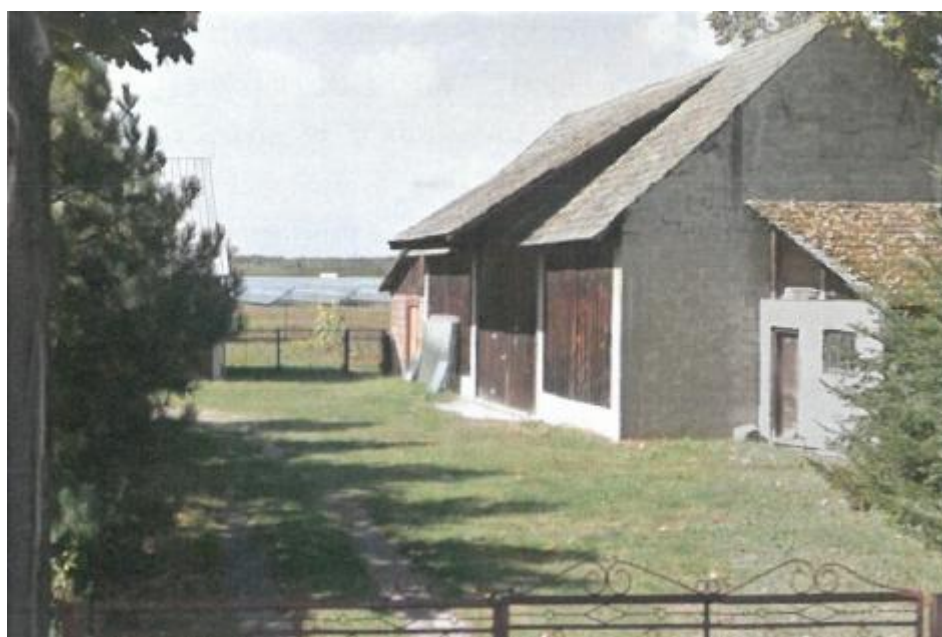
Zdjęcie 10 Widok na instalację fotowoltaiczną z odległości ok. 140 m.
